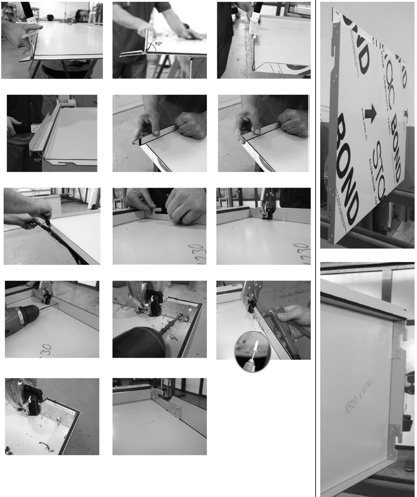
Figure 2b – Façonnage des cassettes (Usinage/Assemblage)
